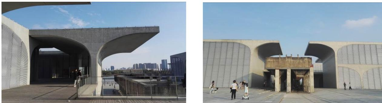
图4 龙美术馆的伞拱结构和原型“煤漏斗”
