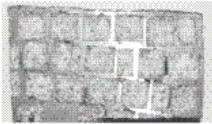
图 8 MGCM 遮弹层内部结构
